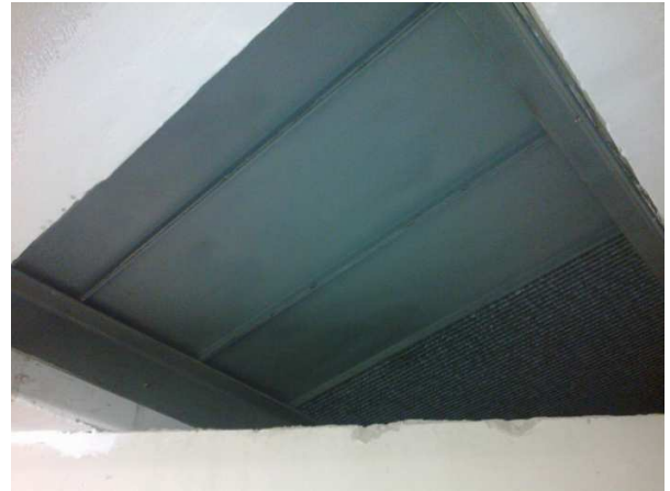
Foto 2 e 3, lamiere e grigliati a chiusura fondo fossa inferiore q.ta +3,52
