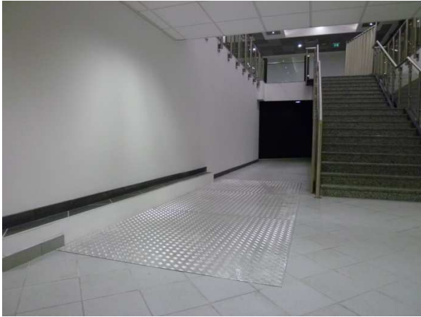
Foto 2 e 3, lamiere e grigliati a chiusura fondo fossa inferiore q.ta +3,52
