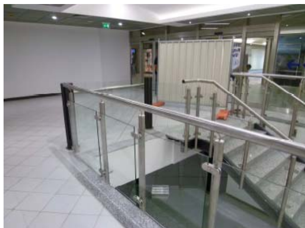
Foto 2 - Foto stato di fatto q.ta +6.61
