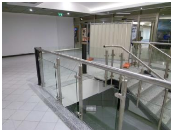
Foto 2 - Foto stato di fatto q.ta +6.61
